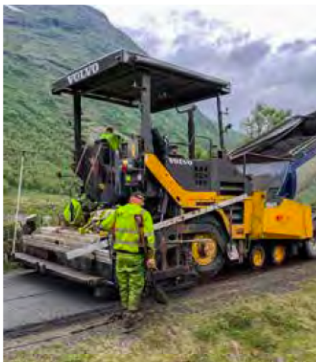
Asfaltleggingen skjedde med stor utlegger og 11 tonns kombivalse.
