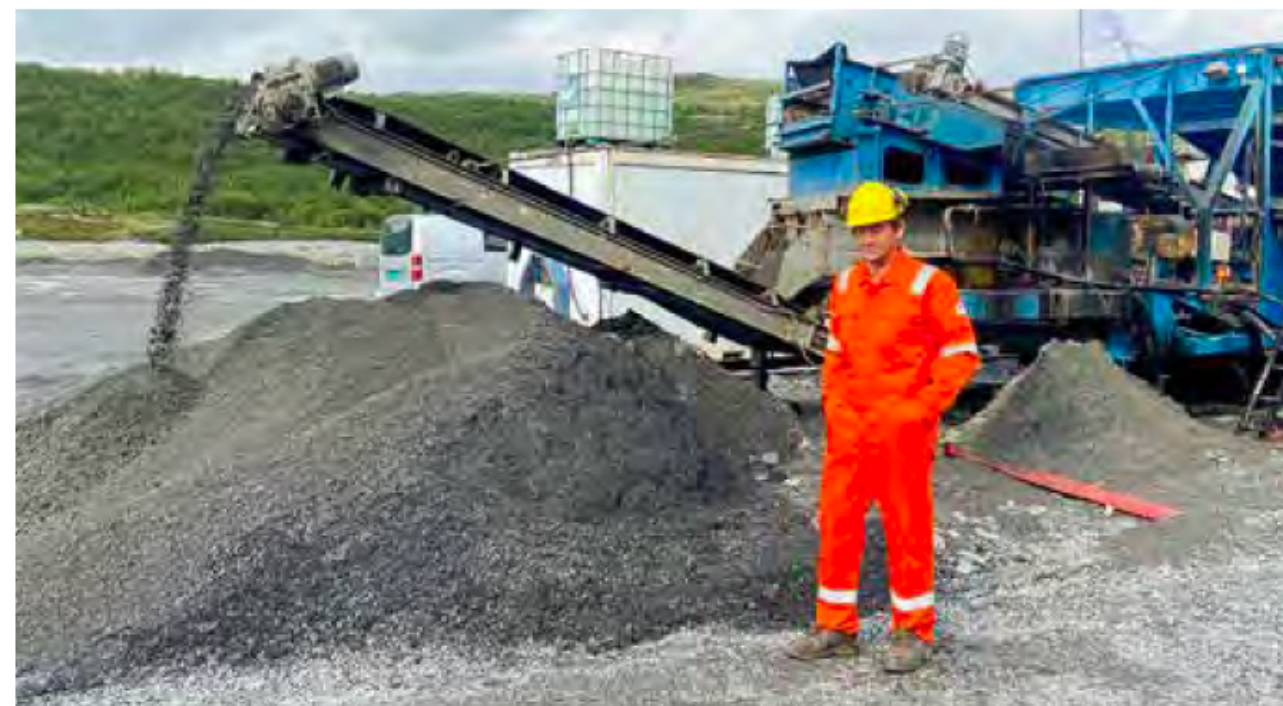
Produksjonsansvarlig Tom Arne Nystuen i KV asfalt ved verket.
